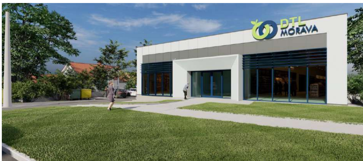
Slika 5,6 i 7 –Jugoistočna i severozapadna fasada
